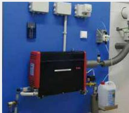
*Instalación de Generador de Vapor en tablero fenólico*
